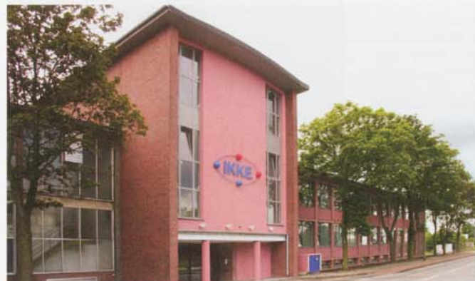
Haupteingang des IKKE in der Kruppstraße mit Logo aus der Eigenproduktion an der Fassade
