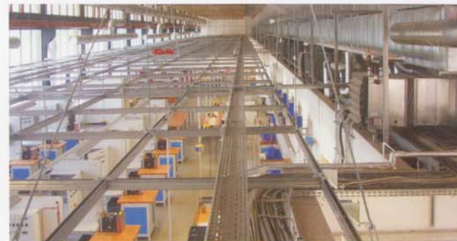
Blick aus dem alten Meisterbüro: Die Zwischendecke vermittelt den Eindruck von Raumhöhe. Aufgeteilt in mehrere Segmente wird die Werkhalle durch Zwischenwände unterhalb der abgehängten Versorgungsebene
