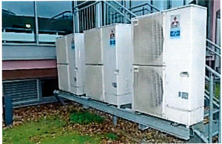
Nicht nur Split-Klimaanlagen benötigen für den Betrieb Kältemittel, auch Wärmepumpen gehören dazu. Personen dürfen aber nur dann an Kältemittelführenden Anlagen und Leitungen arbeiten, wenn sie die Legitimation in Form eines Zertifikats belegen können.
